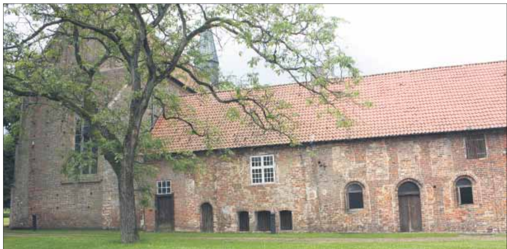
Nur ein kleiner Ausschnitt vom Gelände des Stifts Börstel: Die Stiftskirche mit dem Ostflügel, der momentan ungenutzt ist und dringend renoviert werden müsste.
